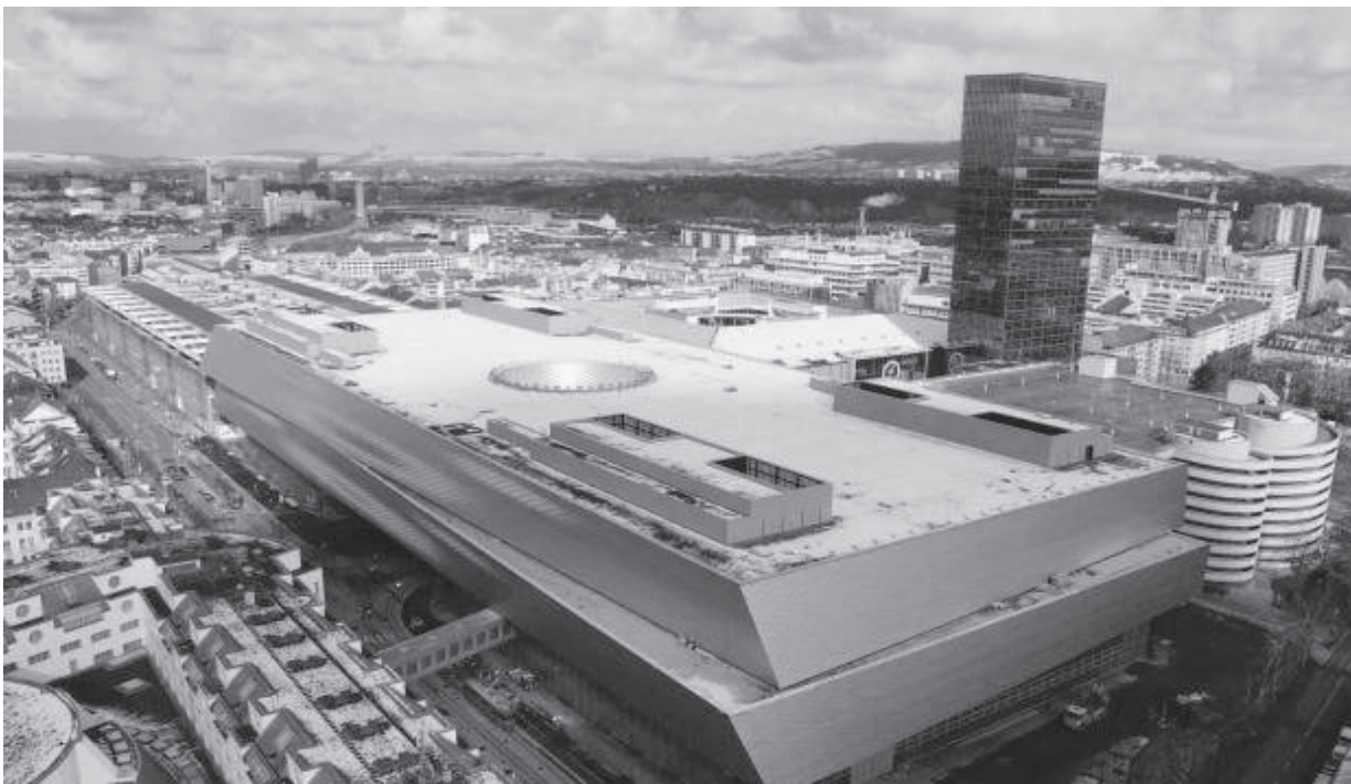
Das Gebäude der Messe Basel, dahinter der Messeturm. Unten links ist das Kongresszentrum.
